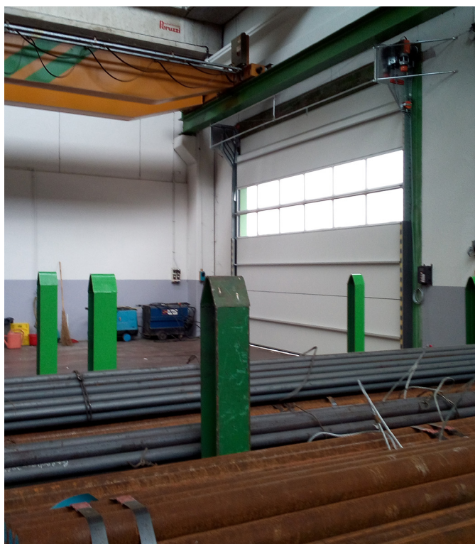
Portone sezionale rigido in manutenzione ordinaria.
