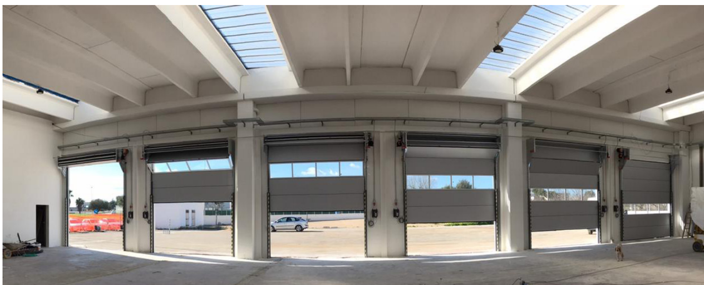
Installazione di sezionali ad impacchettamento interno in un magazzino di stoccaggio.
