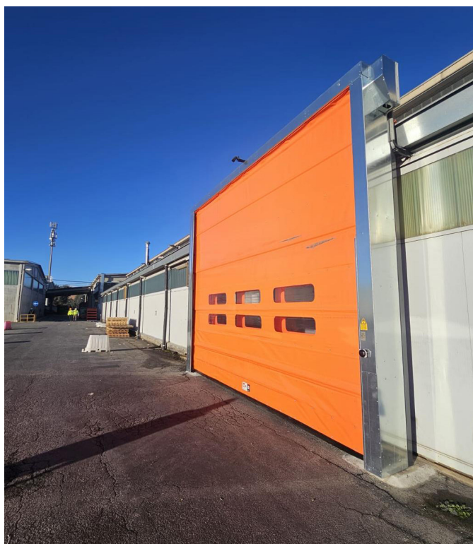
Ripristino porta rapida doppio manto dopo scontro notturno
