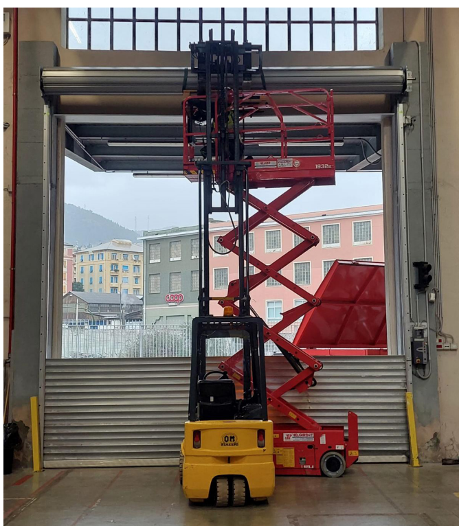
Riparazione manto serrande industriale durante un nostro intervento
