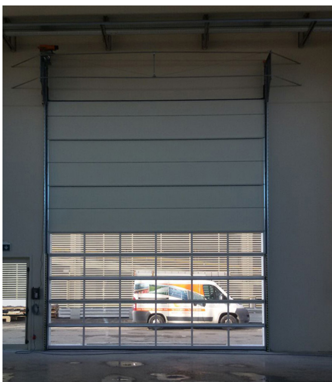
Installazione di sezionale vetrato per maggiore luminosità.
