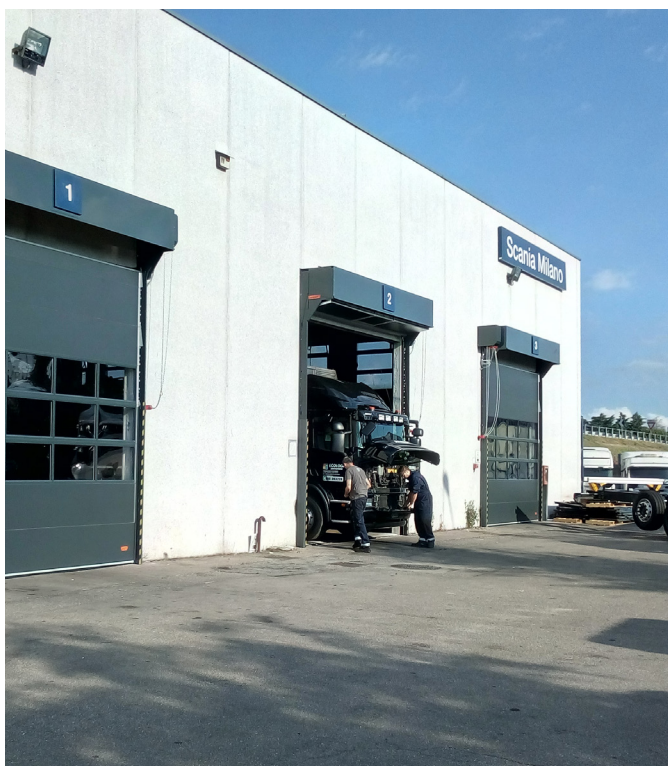
Portoni rigidi ad impacchettamento esterno dopo manutenzione.
