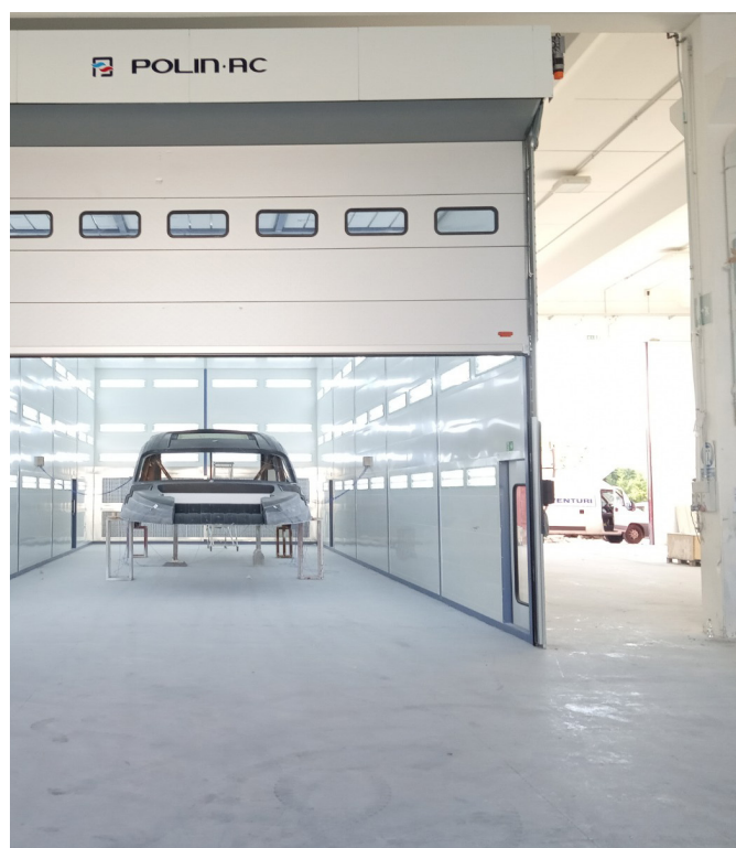
Installazione di sezionale in camera di verniciatura.
